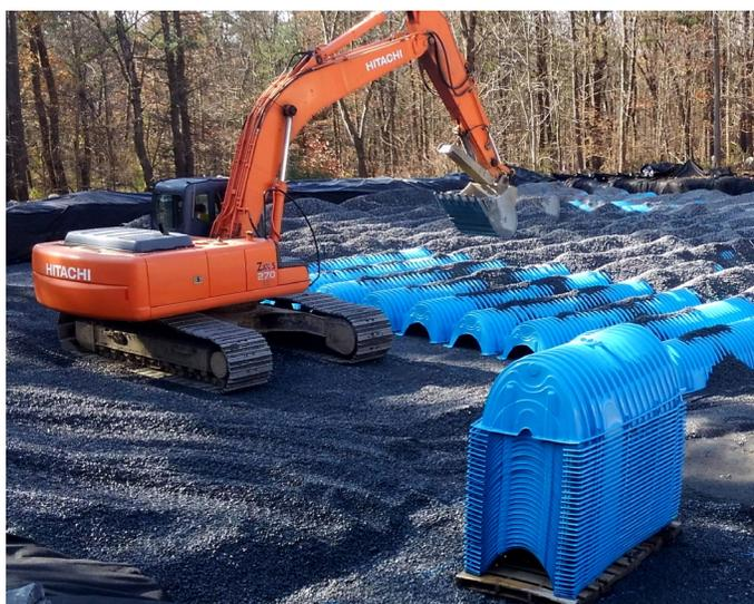
**LES CHAMBRES CULTEC S'EMPILENT SUR DES PALETTES POUR FACILITER LE CHARGEMENT, LE DÉCHARGEMENT ET LE STOCKAGE**
