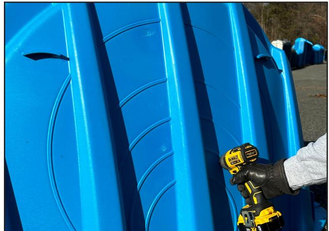
La coupe ne peut être effectuée que sur les embouts ou dans les portails latéraux. Les tuyaux ne peuvent pas être insérés dans la paroi latérale de la chambre, sauf s'ils se trouvent à l'intérieur des lignes de coupe du portail latéral.
